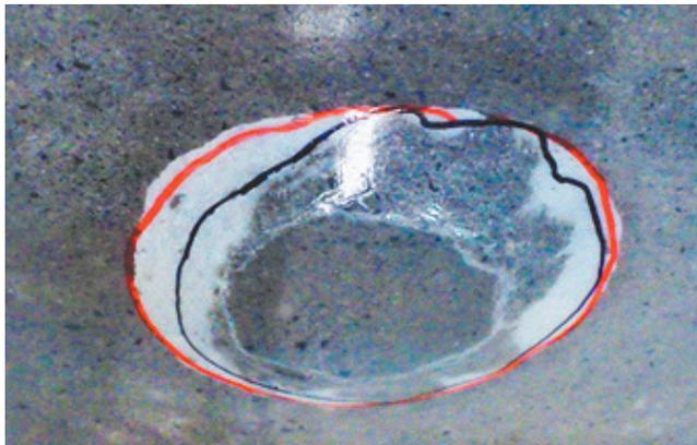
「ボンド KEEPメンテ工法 VMクリア」は、コンクリート表面に透明なポリウレアウレタンを被覆することによりコンクリート片のはく落を防止する工法です。
