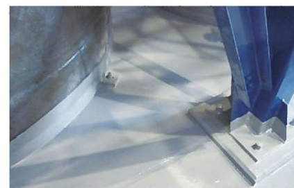
化学工場床面防水
