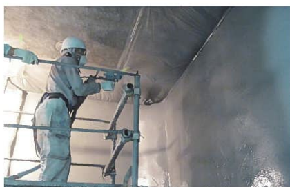
発電所ピット内面
