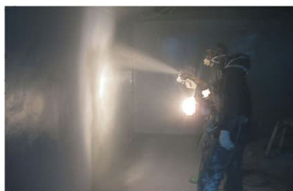
製鉄所排酸槽内面
