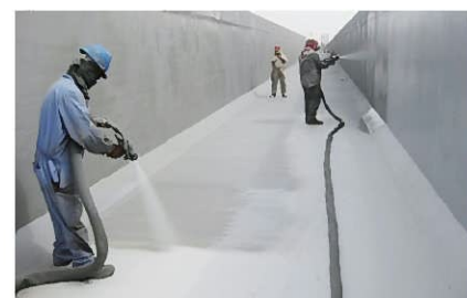
化学工場水路内面
