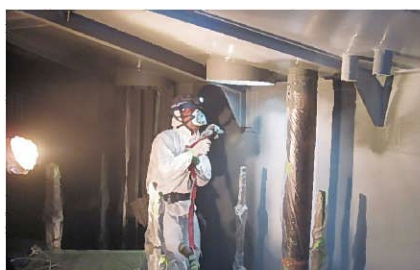
自動車工場タンク内面
