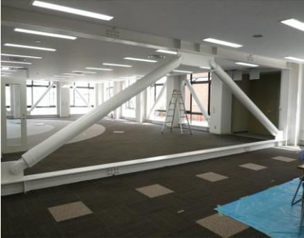
鉄骨ブレース接着工法は、鉄骨ブレース増設による耐震補強工法のひとつで、従来工法のあと施工アンカーによる間接接合部分をエポキシ樹脂による接着接合で定着する工法です。
