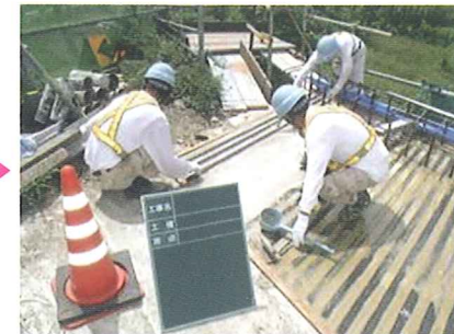
トレカ®ラミネート板貼り付け工
