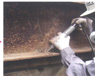
鋼材の素地調整 (超音波振動剥離工法)
