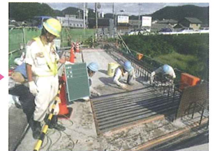
トレカ®ラミネート板貼り付け工
