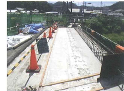
下地処理完了
