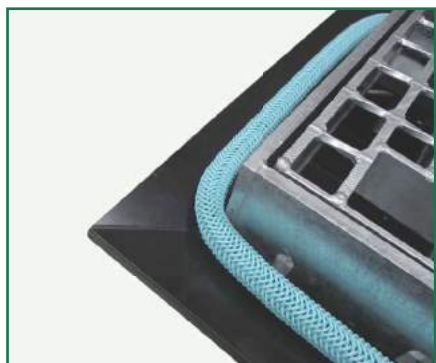
導水パイプと防水層接合部
