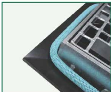
導水パイプと防水層接合部
