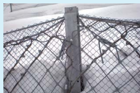
ひし形金網の変形状況 (φ3.2×50×50 の変更により補強効果あり)
