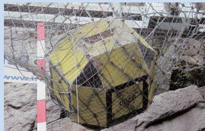
補修したネットに再度重錘を落下し捕捉
