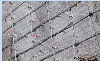
切断したネットを現地で補修した状況
