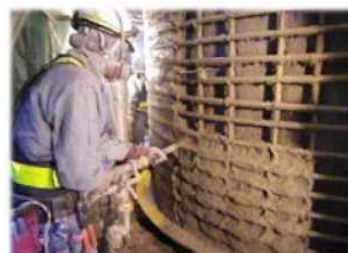
湿式吹付け状況 (SRShotcrete工法)
