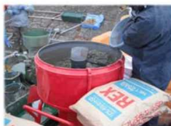
PCM混練状況 (SRShotcrete工法)
