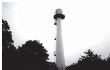
給水塔・煙突の補強
