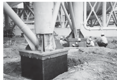
工場構造物の補強
