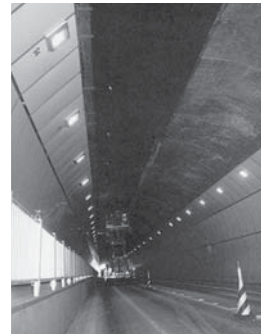
トンネルの補強
