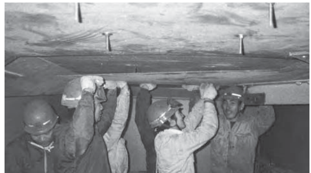
鋼板取付け工
