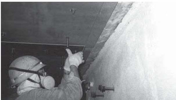
スプライス板取付け工
