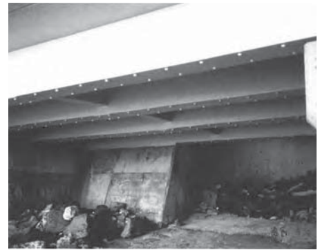
鋼板補強と防水ランニング併用工事
