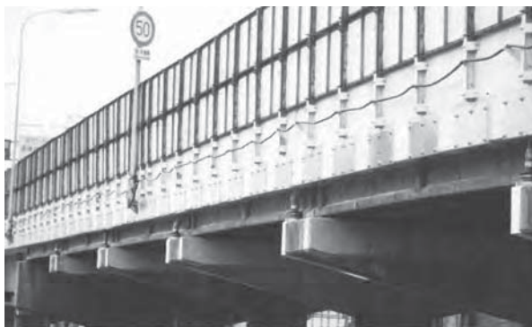
高欄の鋼板補強と樹脂防水
