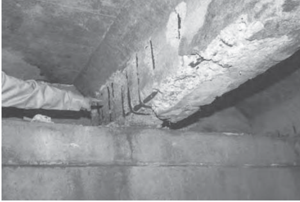
錆鉄筋の状況を把握する
