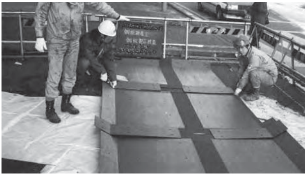
鋼板の作成および搬入
