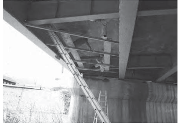
橋梁床版の調査風景
