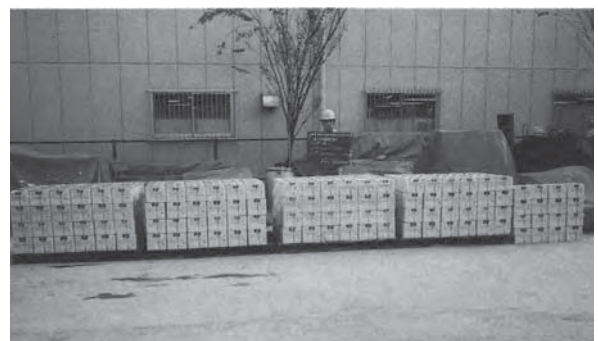
材料検収 (使用材料の注入材、シール材の数量を現地で確認します)
