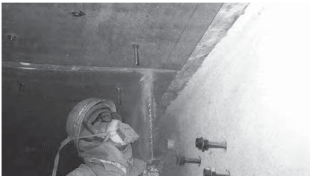
アンカー設置工
