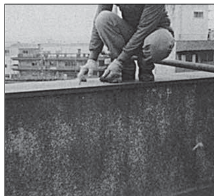
パラペット天端の施工
