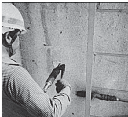
モルタル面への施工
