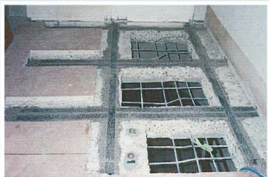
設置開口部まわりの補強
