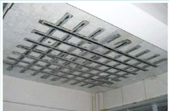
床スラブ下面中央部への貼付曲げ補強
