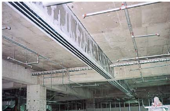
積載荷重の増加に伴う梁部材の曲げ補強
