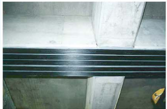
梁下面への全面的な貼付曲げ補強
