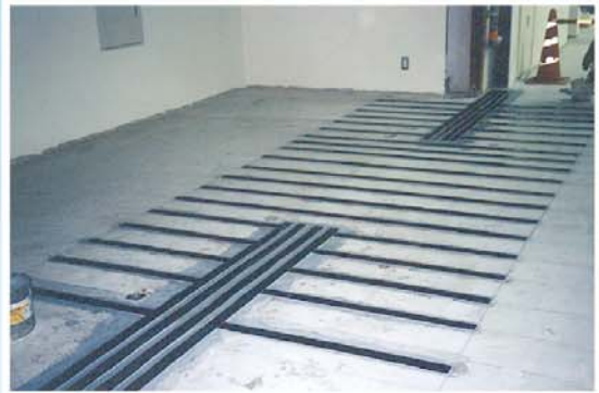
梁上面への貼付曲げ補強
