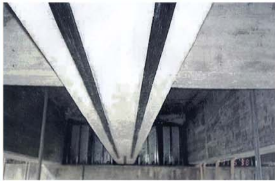
梁下面への貼付曲げ補強
